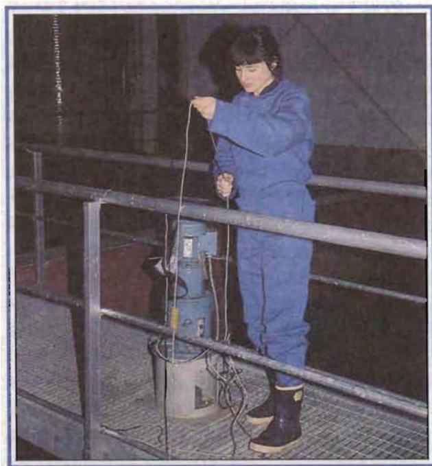
Driftsassistanse gir renseanleggene regelmessig kontroll av utstyr
