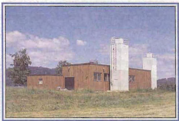
Maura renseanlegg ble bygget under "fellesprosjektet"
